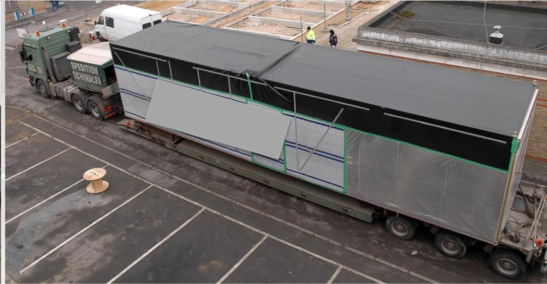
Le socle a été préparé sur le site pendant que les modules étaient fabriqués en usine : **compression du planning**
