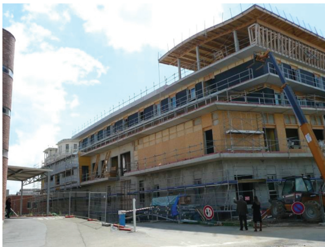
Figure IV : Montage de la façade - Panneaux de bois
