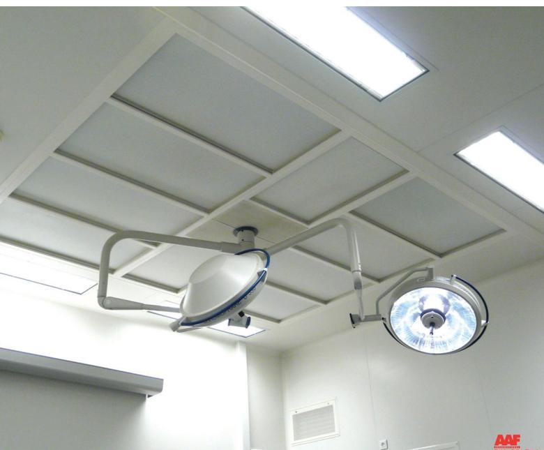
Figure I : Plenum Bloc Opératoire à « Fût Soufflant »
