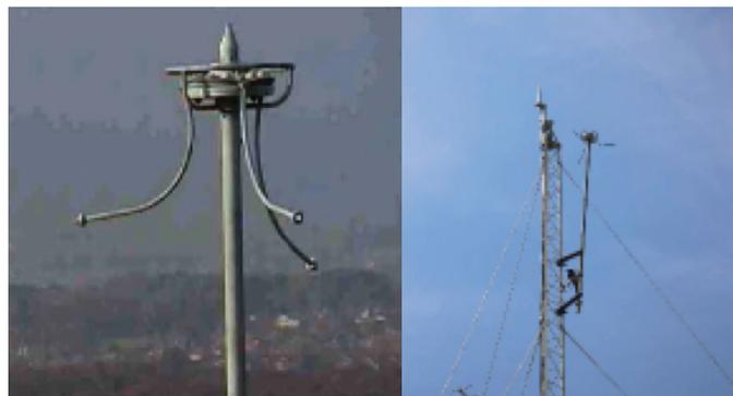
Photos I et II : Sources radioactives Helita (une d'elle se trouvant sous une antenne située sur le toit d'un hôpital !).
