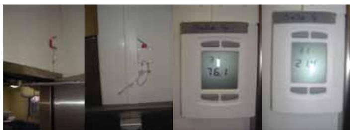
(Figure 1) : Capteurs de pression et Afficheurs installés dans les salles. L'affichage de l'hygrométrie (76,1 % sur la photo) est intermittent avec celui de la température (21,4°C), tandis que celui de la pression reste permanent (31 Pa).
