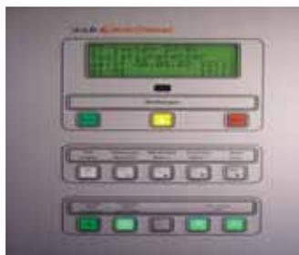
Image IV Contrôleur permanent d'isolement (CPI) 107TD47 (photo fournie par la société Bender, Allemagne)
