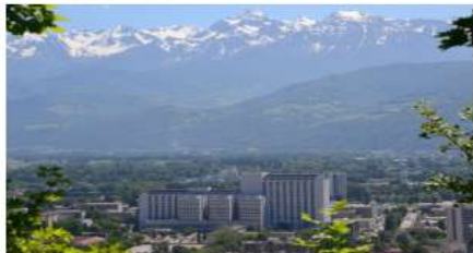
site nord du CHU de Grenoble
